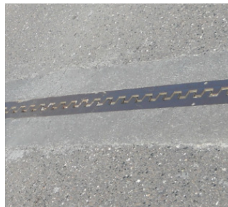
Configurazione del nuovo giunto
