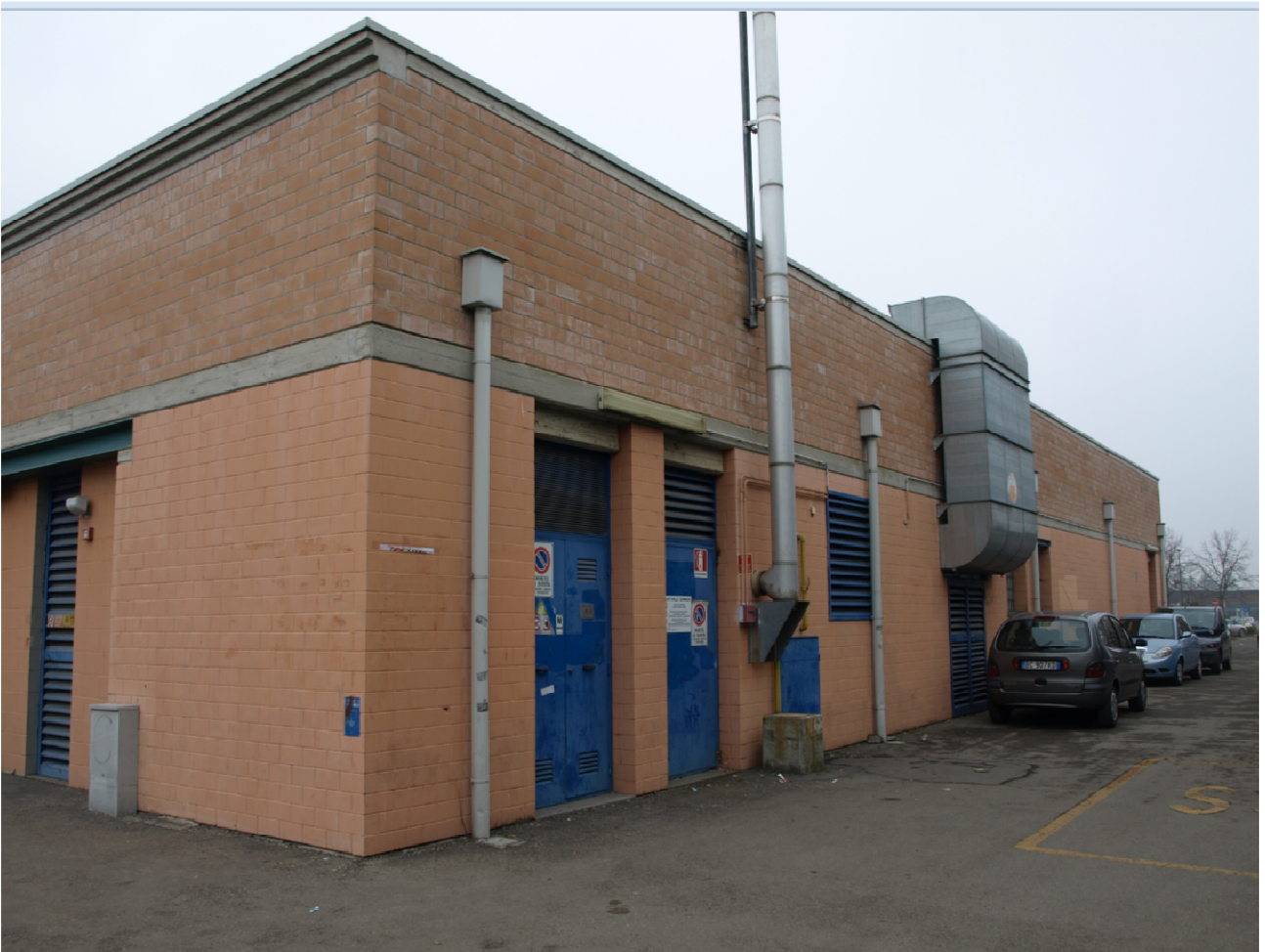
Prospetto verso scuole
