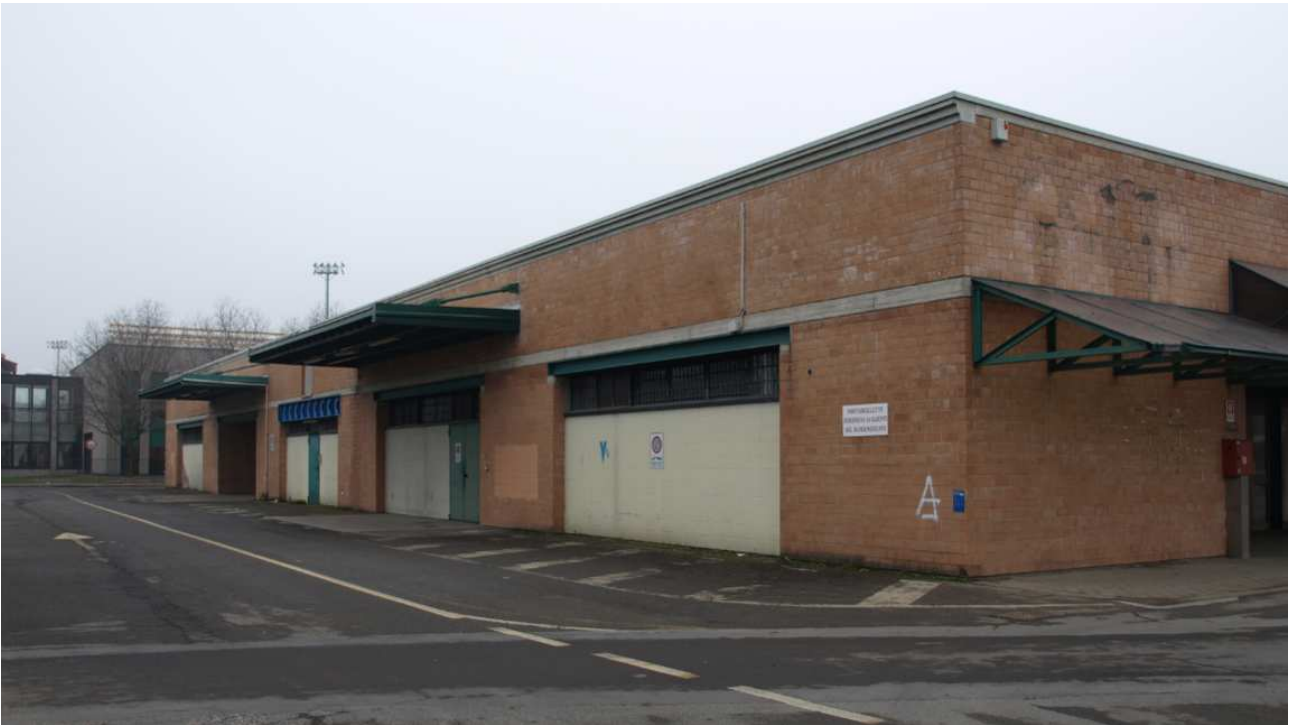
Prospetto verso parcheggio
