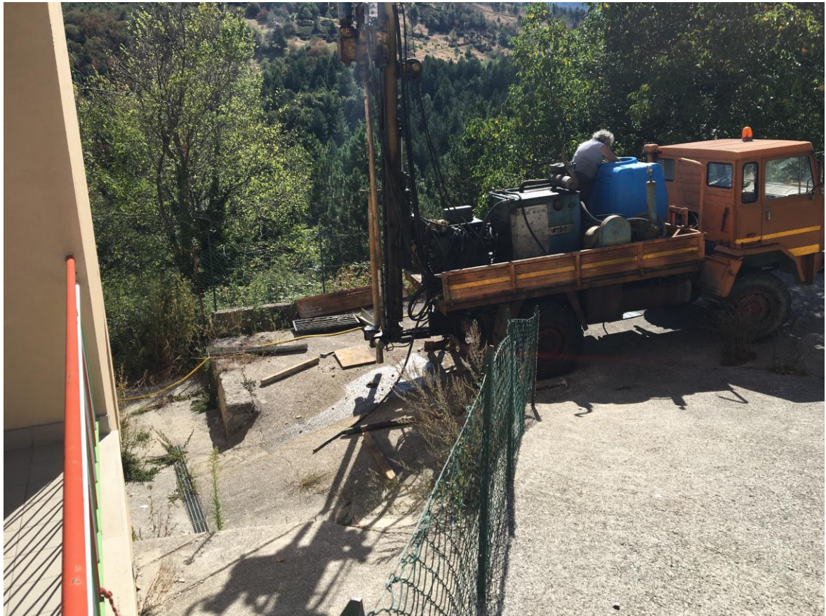
La foto mostra l'esecuzione del sondaggio effettuato sulla lato meridionale dell'edificio scolastico.
