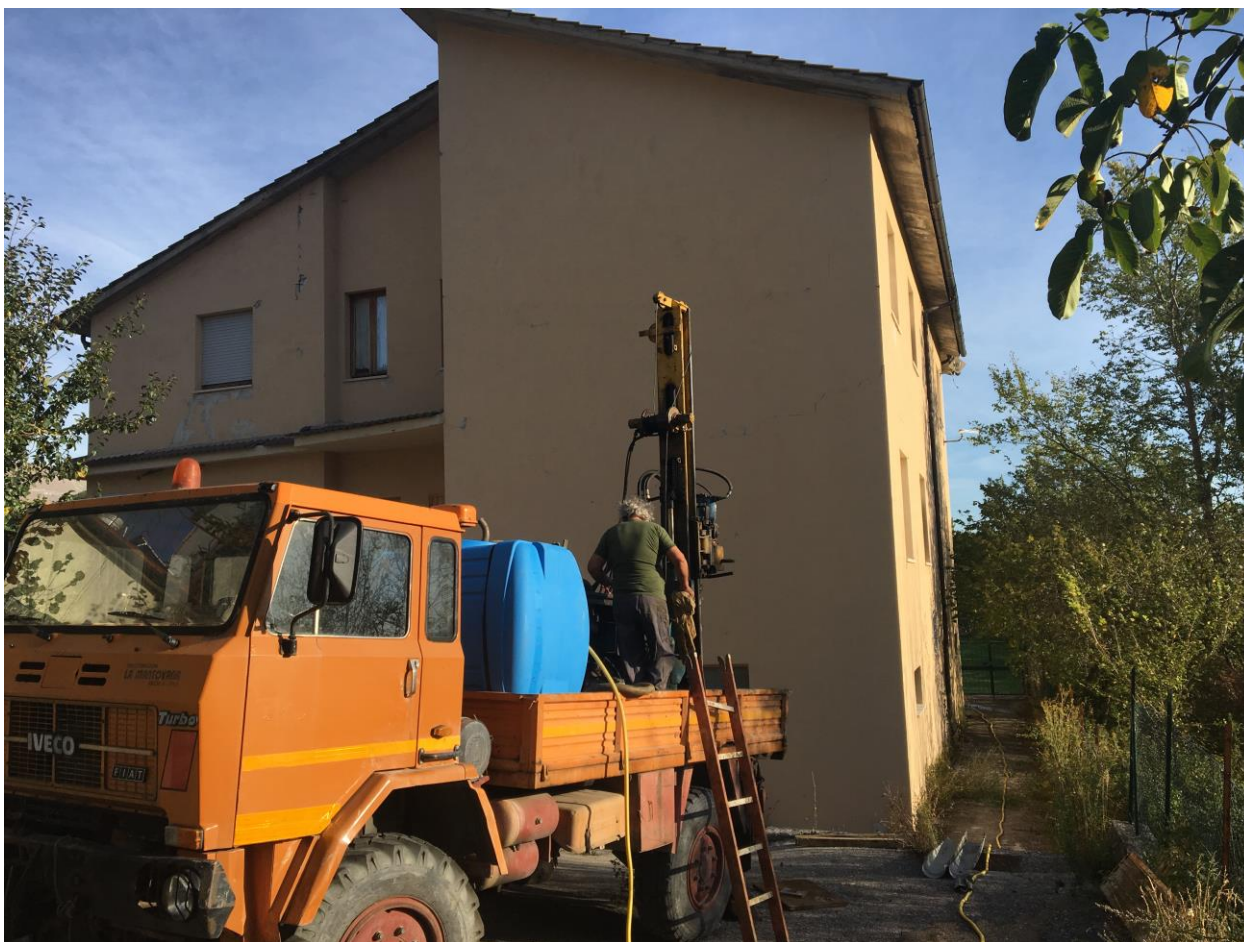
Fig. 3 : Sondaggio geognostico in fase di esecuzione. Si noti sulla destra la recinzione che delimita il ciglio di scarpata.
