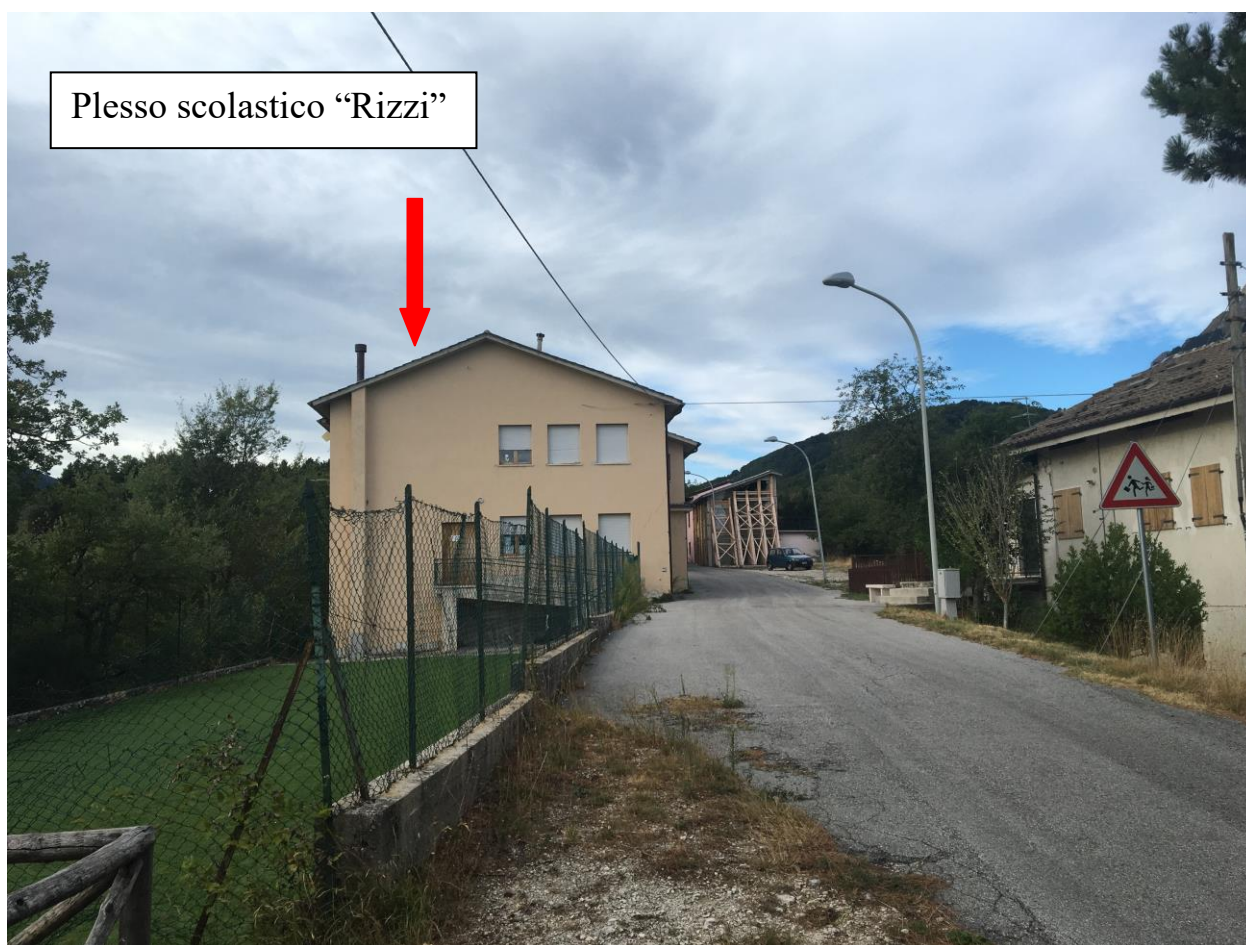
Fig. 2 : La foto mostra l'edificio oggetto di intervento. Si noti la stretta dorsale che si raccorda con le incisioni vallive mediante versanti piuttosto acclivi
