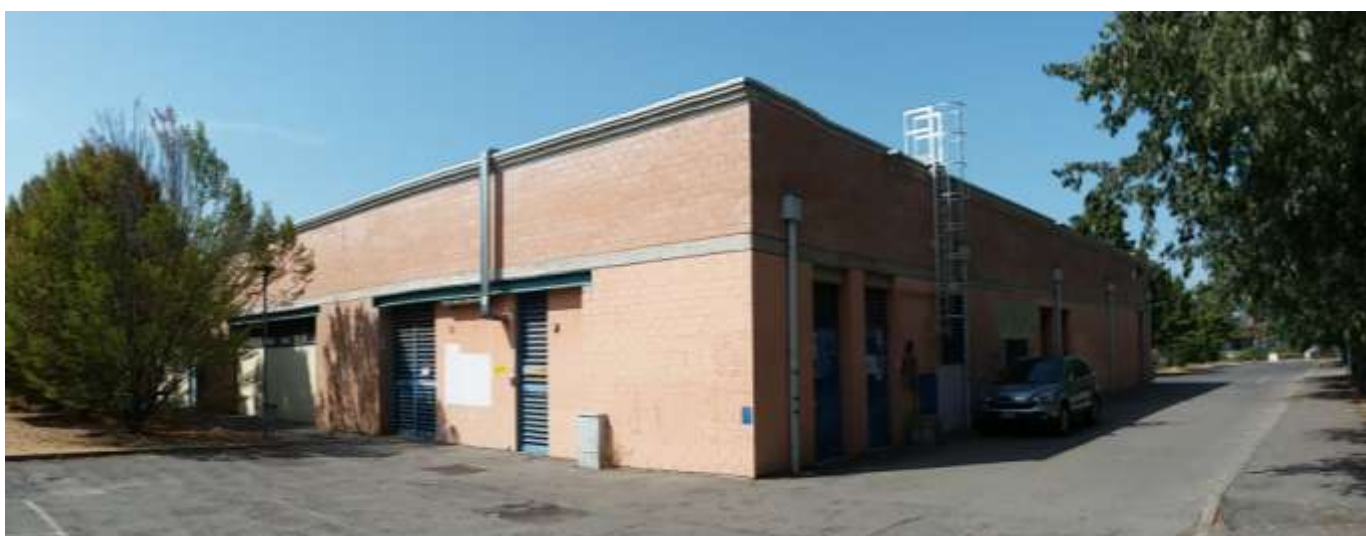
FOTO 3 – vista da Sud/Est
