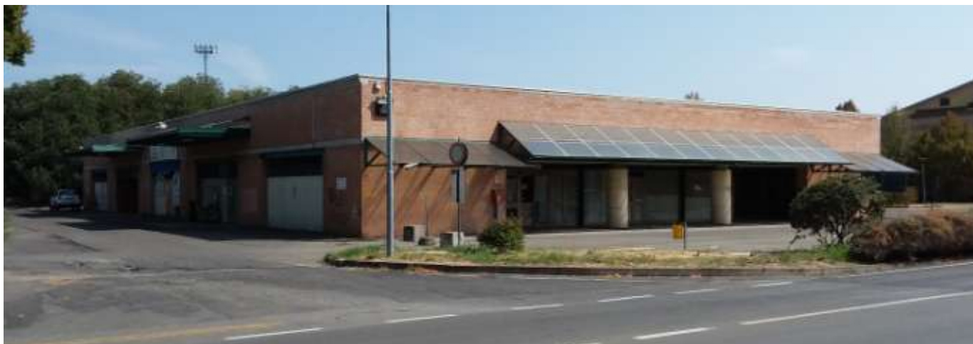
FOTO 1 – Vista da Nord/Ovest
