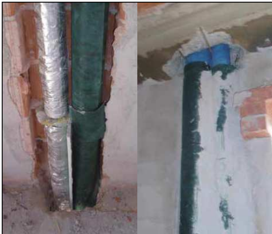
Figura 61: accorgimenti costruttivi (particolari isolamento acustico tubazioni, fonte indexspa.it )
