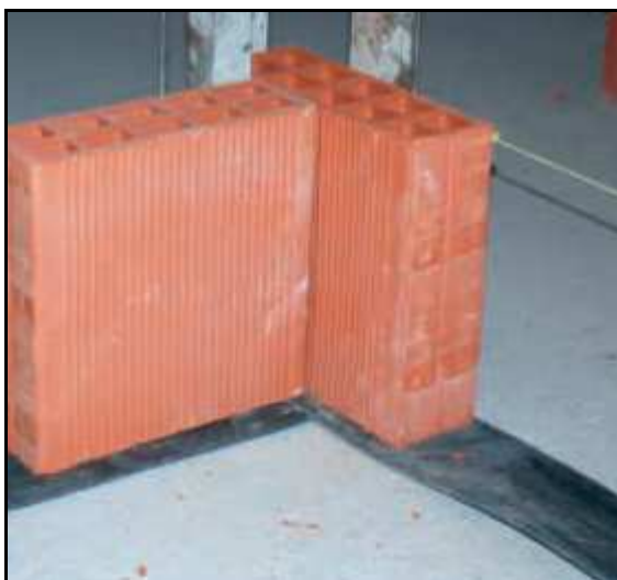
Figura 42: accorgimenti costruttivi (posa fascia tagliamuro sottoparete)
