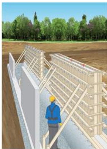
Cassaforma verticale allestita in cantiere
