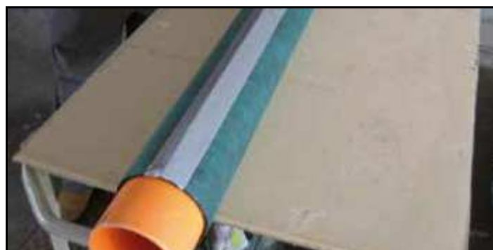
Figura 59: accorgimenti costruttivi (isolamento acustico di una tubazione di scarico, fonte indexspa.it )
