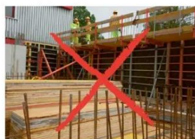
1 Ferri di ripresa non messi in sicurezza
