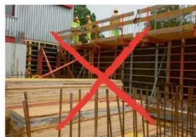
1 Ferri di ripresa non messi in sicurezza
