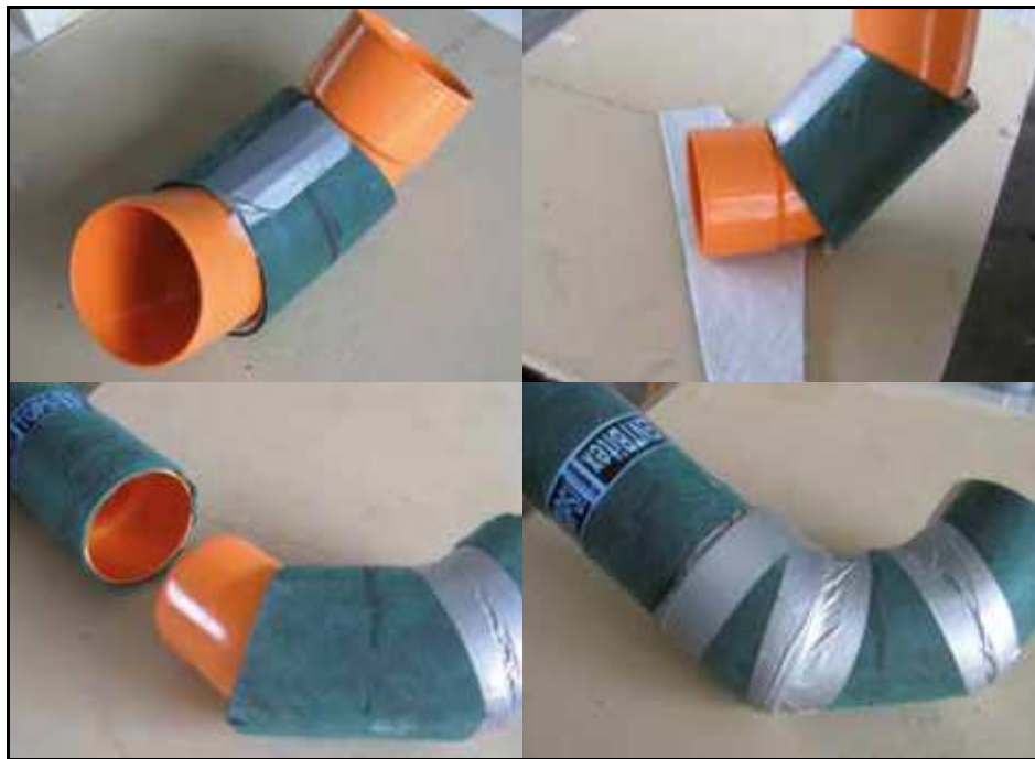
Figura 60: accorgimenti costruttivi (isolamento acustico curva tubazione di scarico, fonte indexspa.it )
