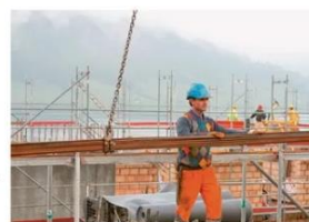
4 Trasporto di un fascio di ferri con gru
