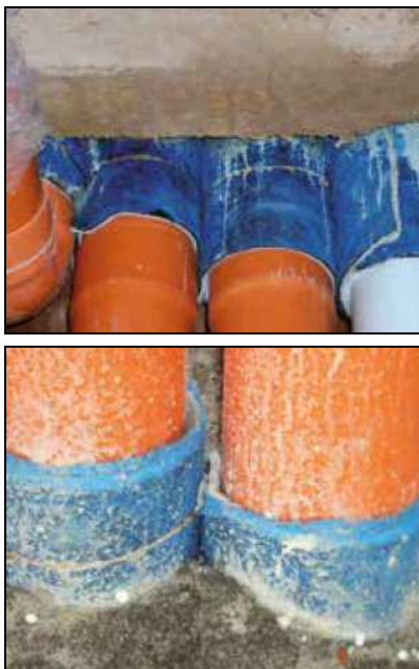
Figura 58: accorgimenti costruttivi (rivestimento impianti nel passaggio solai, fonte indexspa.it )
