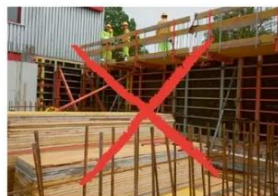
1 Ferri di ripresa non messi in sicurezza
