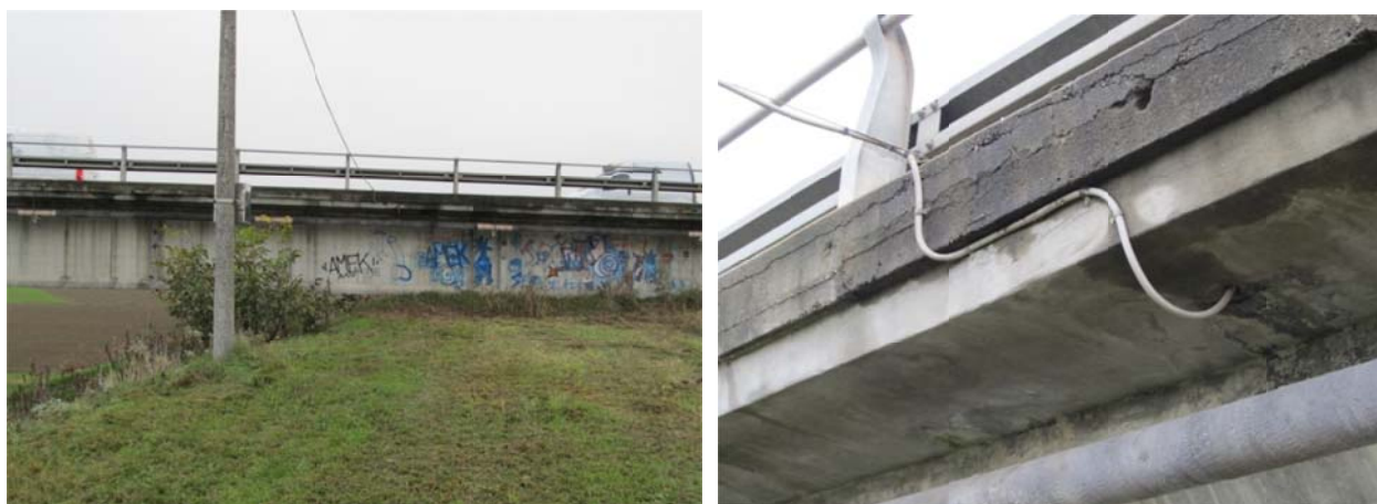
Figura 6.2: – palo con linea aerea BT (foto sx), cavo linea BT entrante nel cordolo lato di monte (foto dx)
