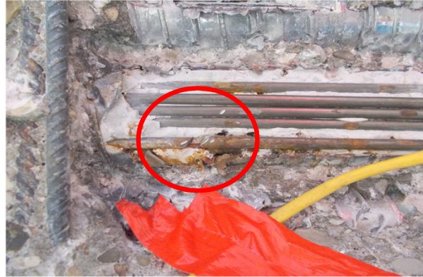
Foto del detensionamento
