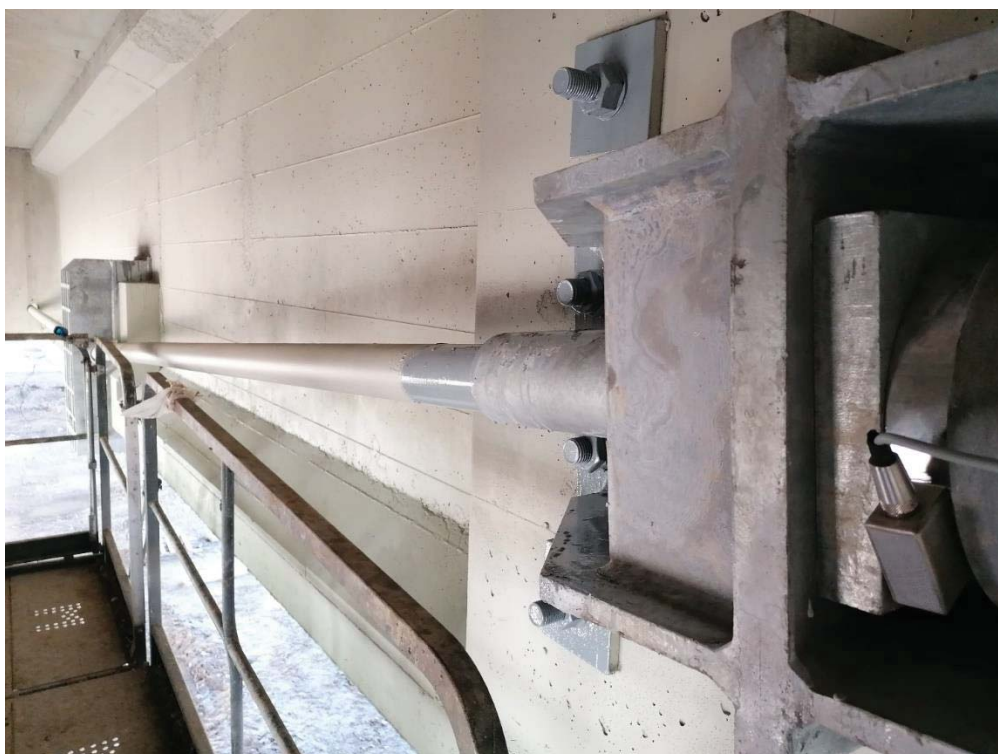
Foto 1: esempio di ancoraggio su carpenteria metallica con cella di carico
