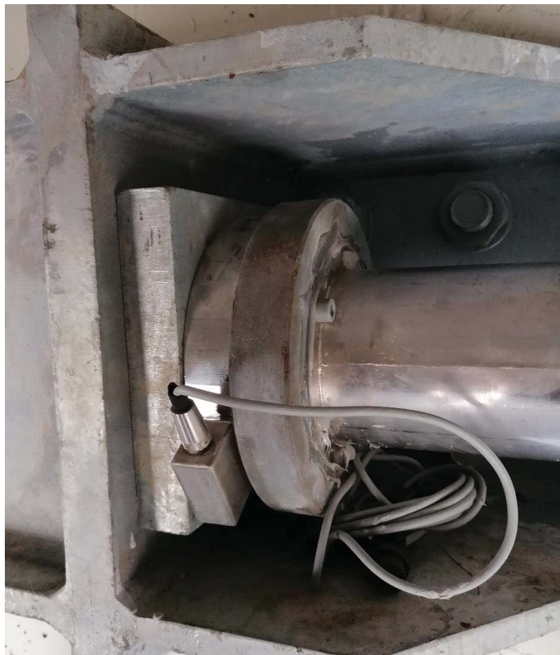
Foto 2: esempio di ancoraggio ritesabile con cella di carico su carpenteria metallica
