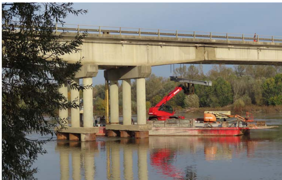
Figura 11.6: – foto con esempio di impiego di pontoni in ambito fluviale per intervento su ponte esistente
