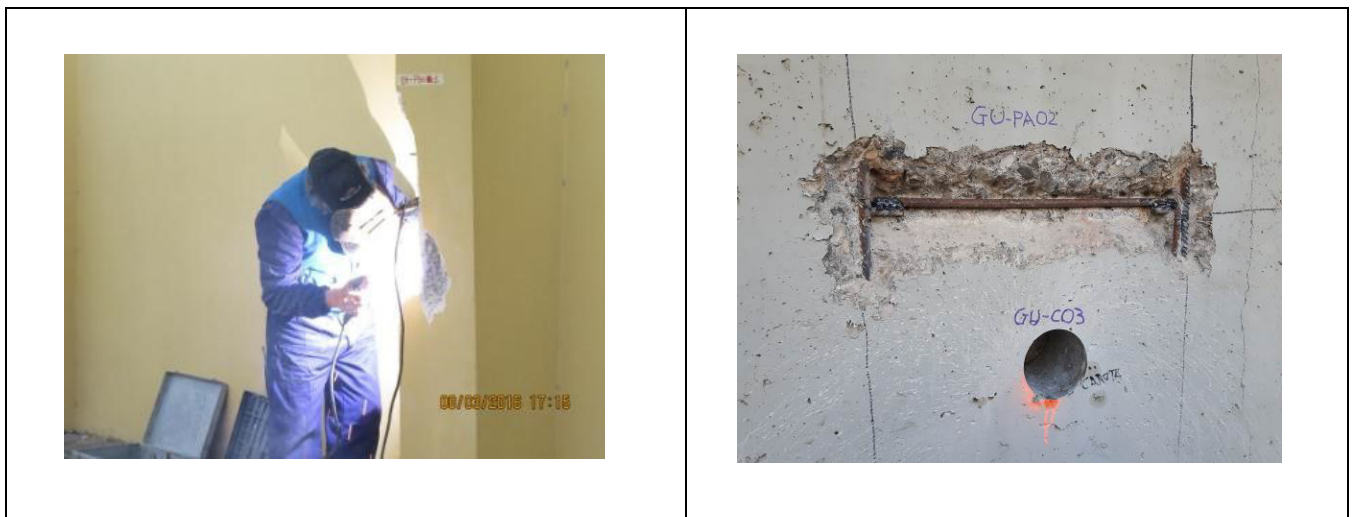
Figura 6: Esempio tipo di ripristino di una barra prelevata
