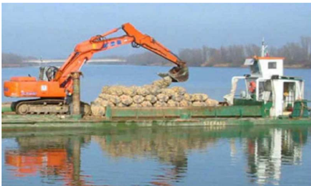
Figura 9.8: esempio di varo delle burghe da pontone
