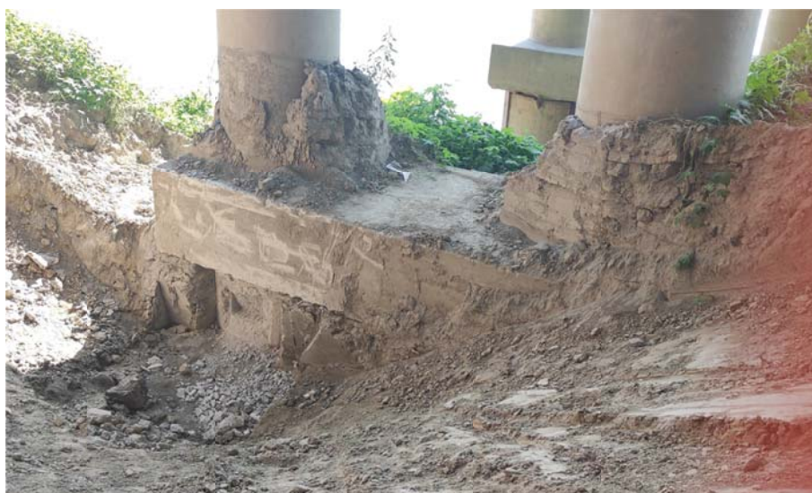
Figura 5.10: – preparazione nicchia per esecuzione prova ecometrica su un palo della pila 6
