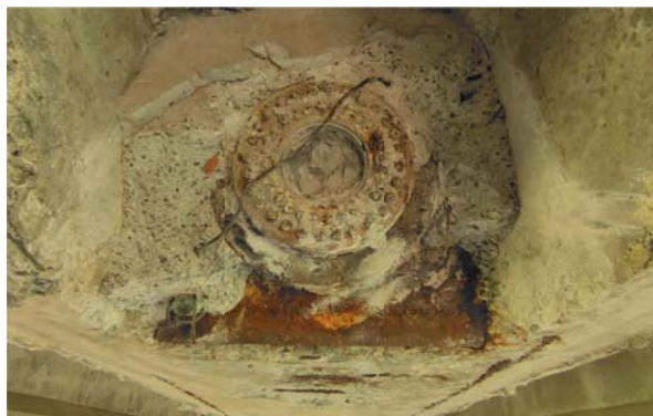
Figura 5.12: – teste di partenza dei cavi di precompressione, rilevate presso le travi su pila
