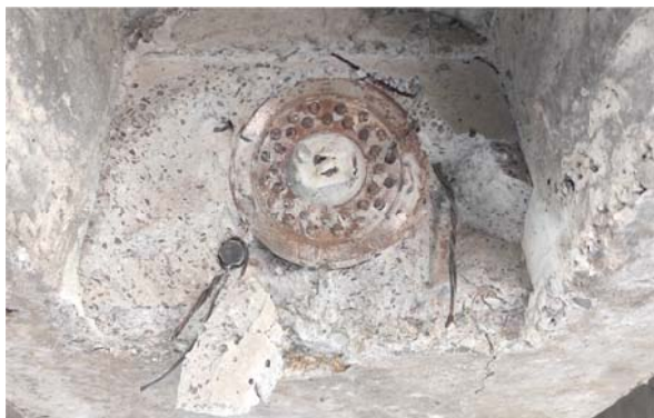
Figura 5.12: – teste di partenza dei cavi di precompressione, rilevate presso le travi su pila
