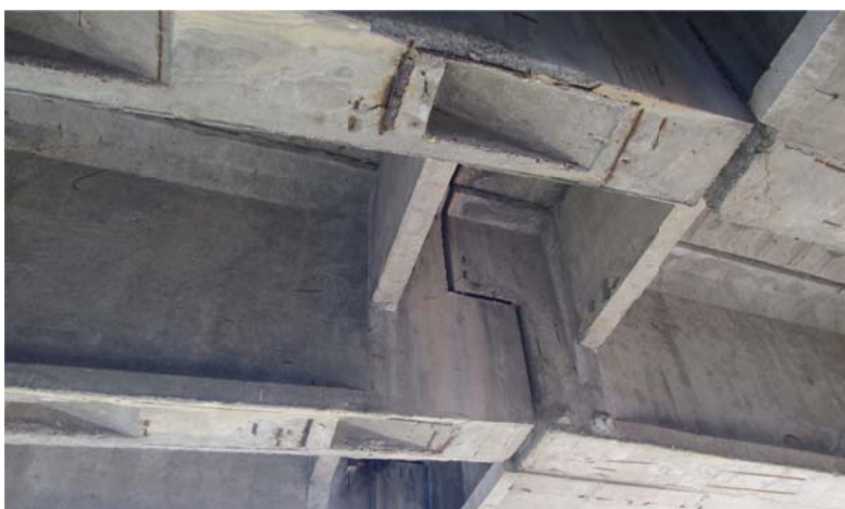
Figura 9.11: – sedi delle testate dei cavi di precompressione
