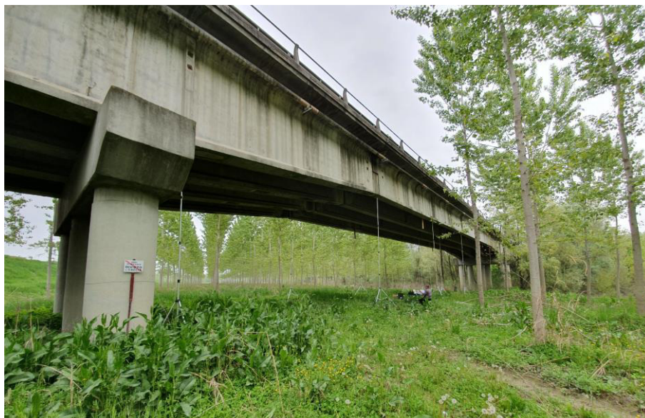
Figura 9: Disposizione dei trasduttori nel ponte lato Dosolo (MN) durante le prove di carico
