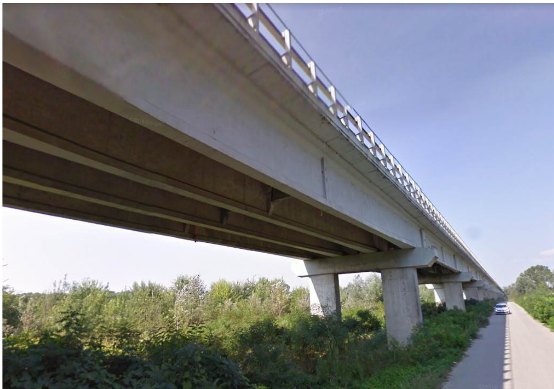
Figura 3: vista delle travi dell'impalcato e di alcune pile lato Guastalla (anno 2018)
