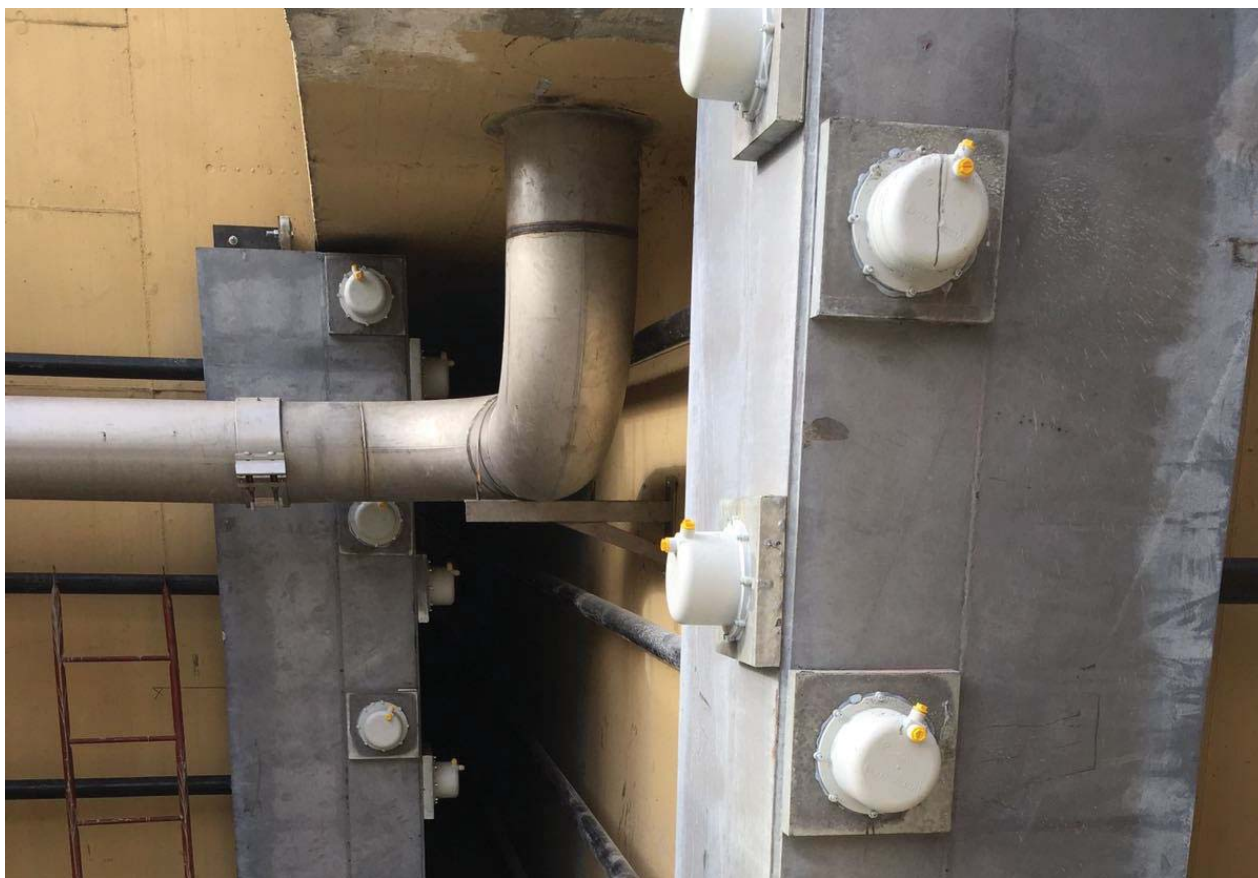
Foto 4: esempio di ancoraggio senza cella di carico su carpenteria metallica con cap standard
