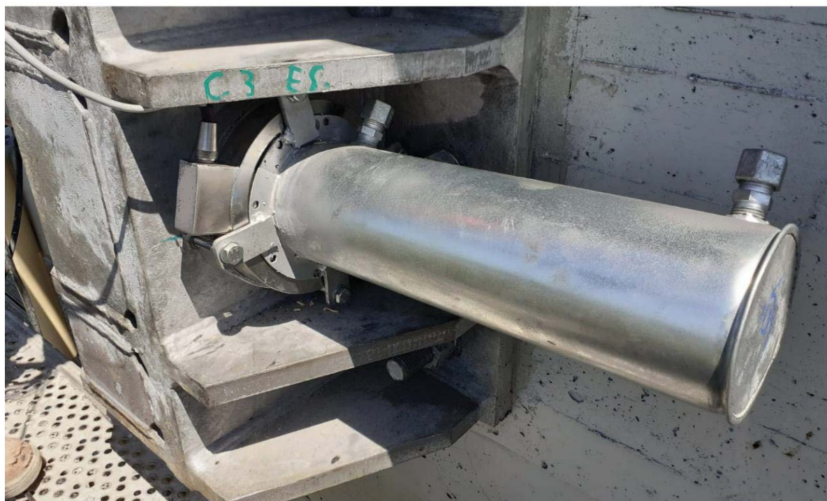
Foto 3: esempio cap di protezione per ancoraggio ritesabile su carpenteria metallica
