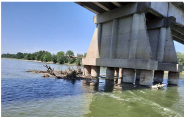
Figura 5.2: – pila 9 con accumulo di materiale in sospensione
