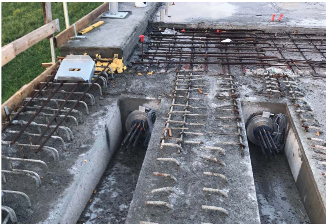
Foto 5: esempio di ancoraggio con cella di carico su ringrosso in calcestruzzo realizzato in opera
