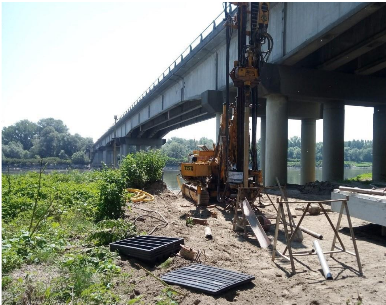
Figura 3: carotatrice Atlas Mustang A 65 T utilizzata per il presente progetto.
