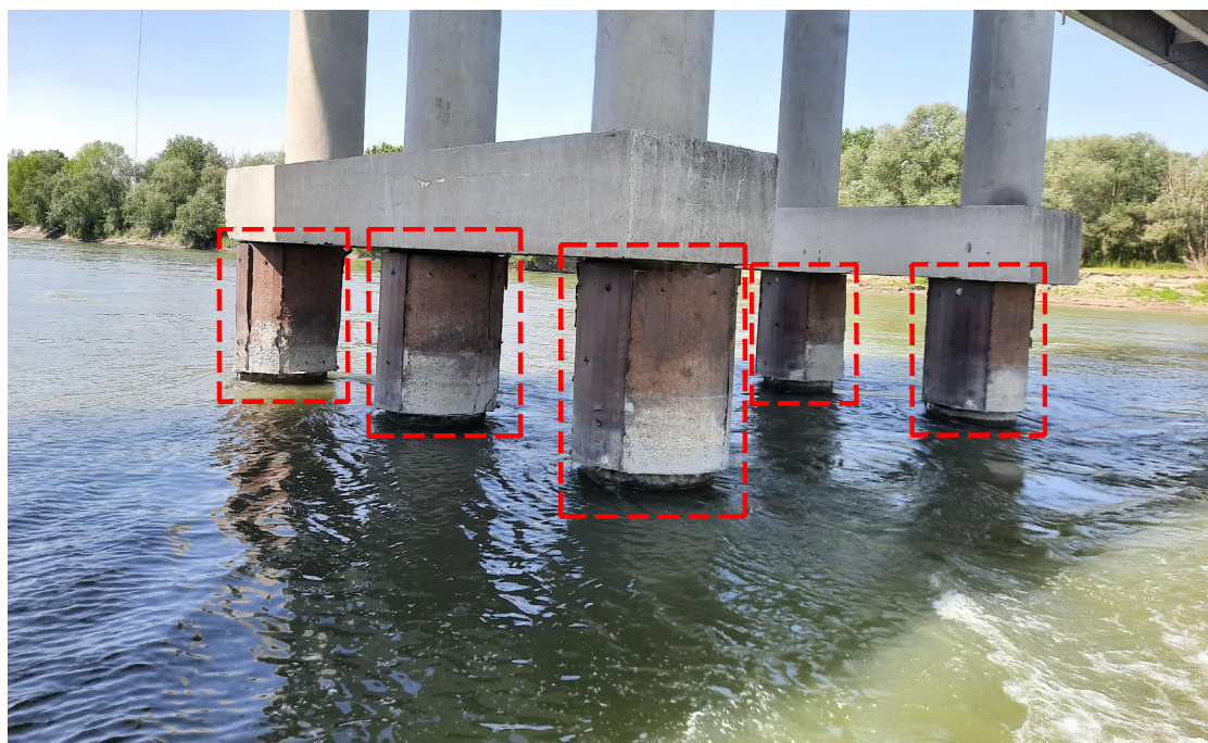
Foto camiciature pile esistenti da rimuovere
