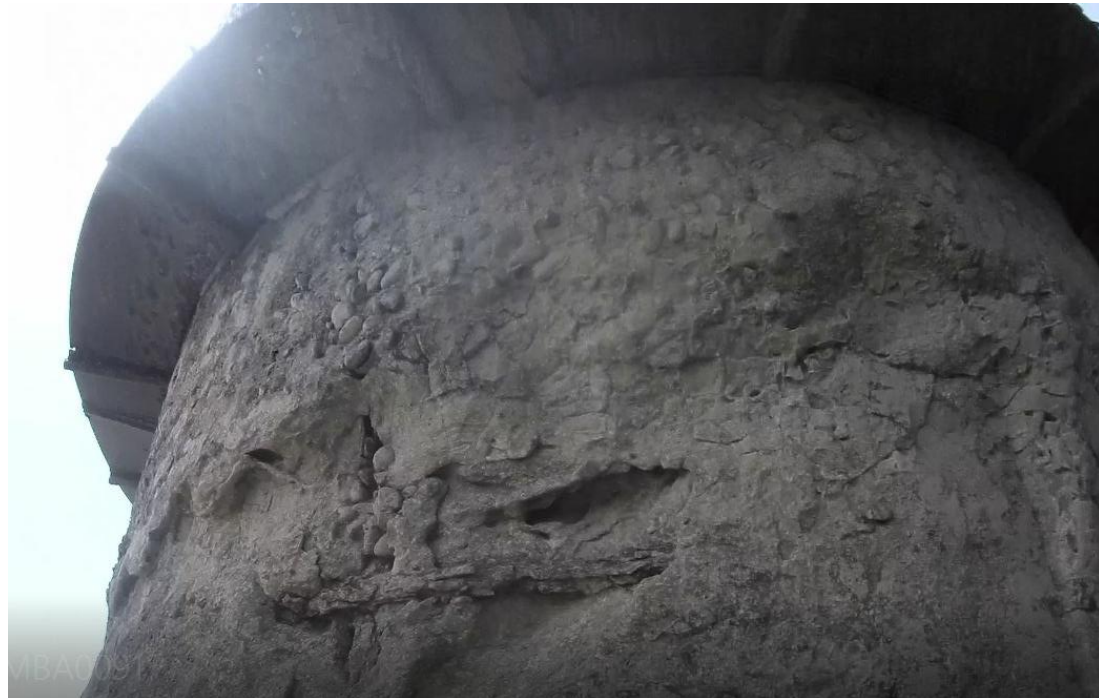
Foto 5 degrado pile fuori acqua
