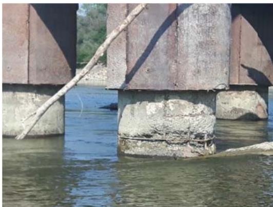
Figura 38 Stato degrado dei fusti in alveo – D=1.5\text{m}
