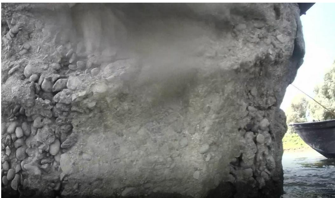
Foto 1 degrado pile fuori acqua
