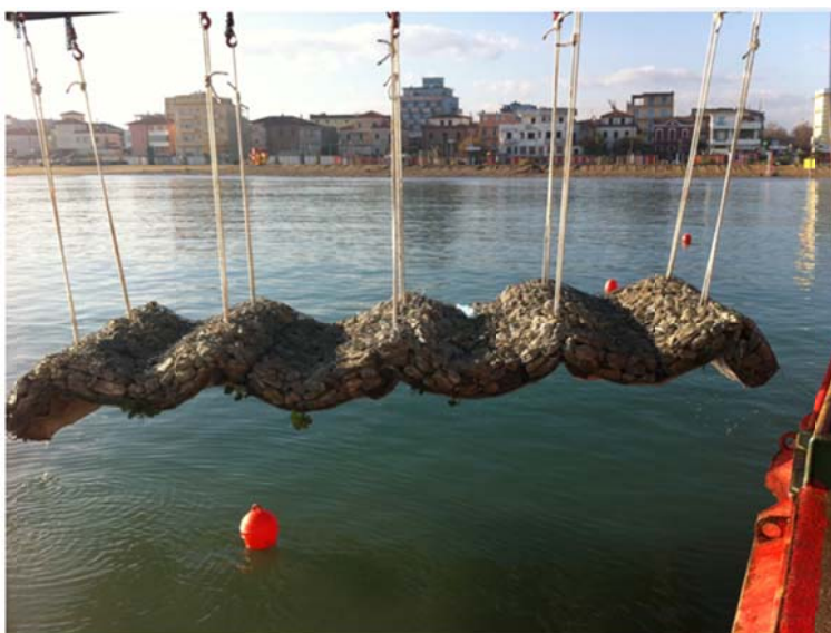
Figura 2 Esempio di materasso con pietrisco
