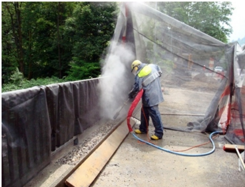
Esempio di modalità operative per idrodemolizione manuale
