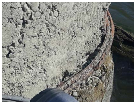
Figura 39 Particolare armatura del fusto in alveo - D=1.5\text{m}
