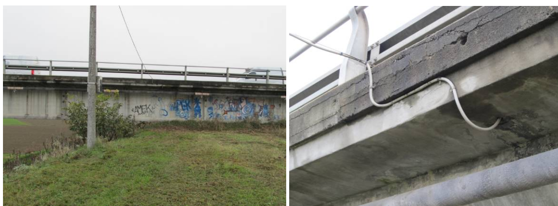
Figura 1 – palo con linea aerea BT (foto sx), cavo linea BT entrante nel cordolo lato di monte (foto dx)
