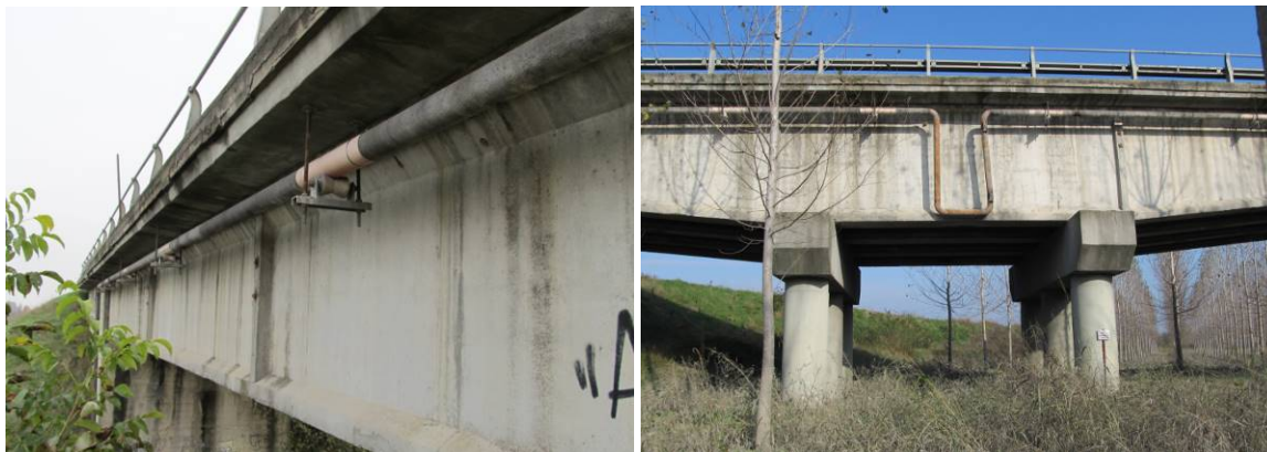
Figura 3 – condotta gas metano lato di monte (foto sx), giunto di dilatazione della condotta (foto dx)
