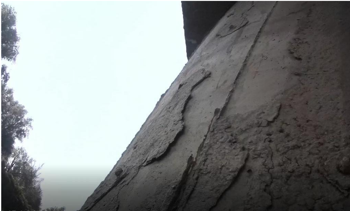
Foto 4 degrado pile fuori acqua
