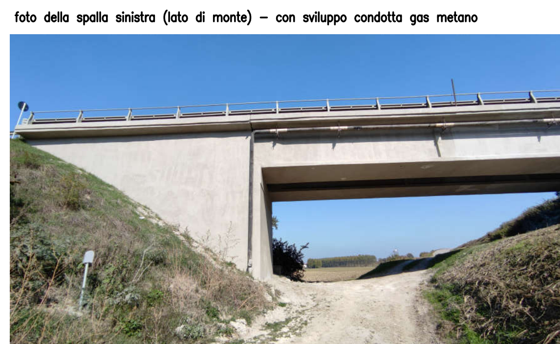
foto della spalla sinistra (lato di monte) - con sviluppo condotta gas metano
