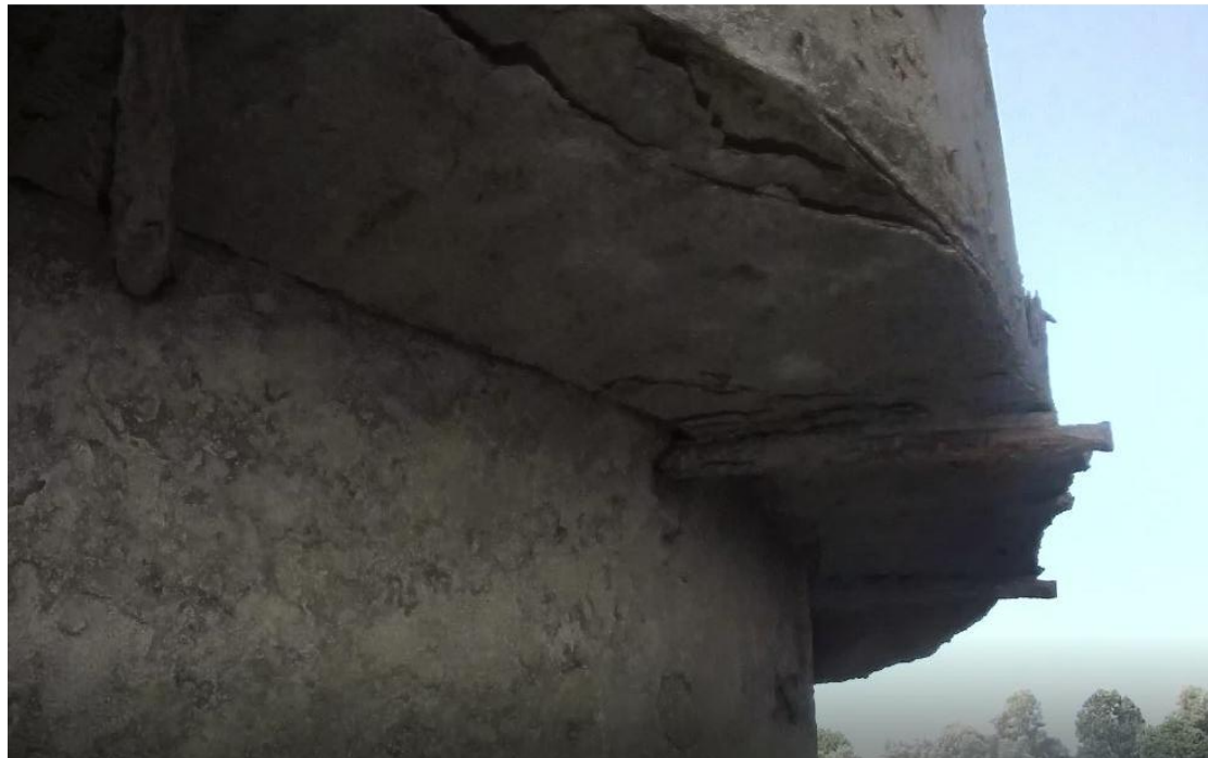
Foto 3 degrado pile fuori acqua
