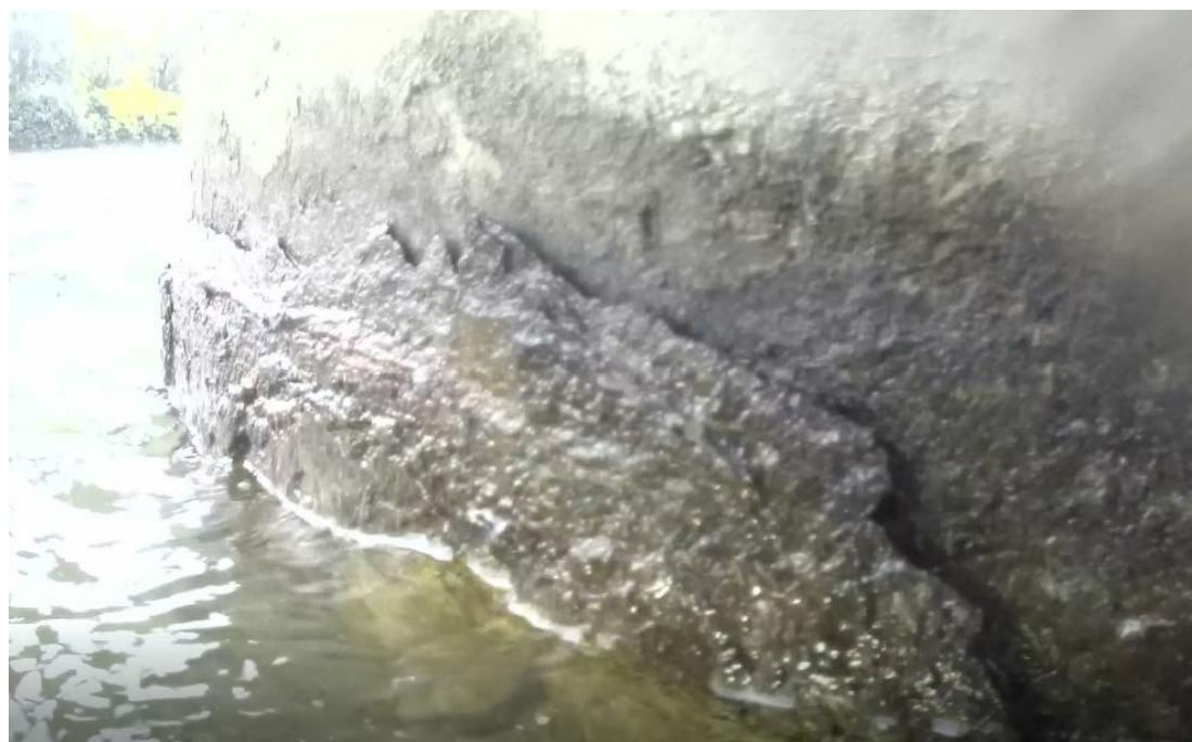
Foto 2 degrado pile fuori acqua
