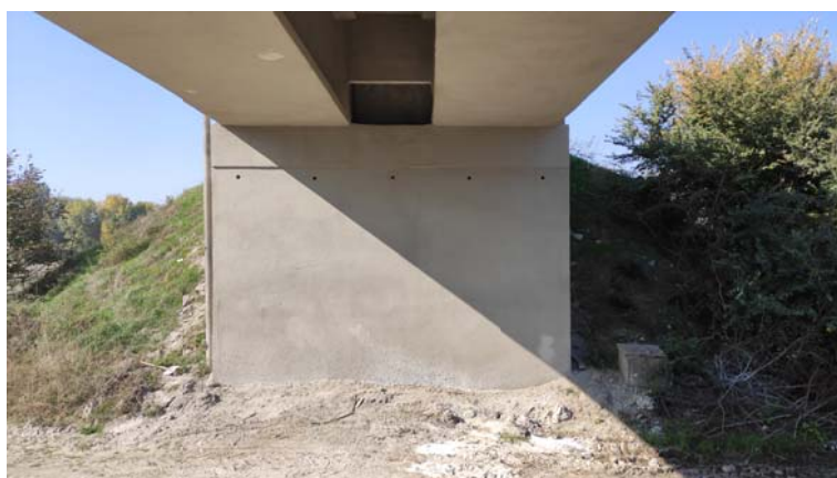
Figura 108 Risanamento sulla spalla lato Dosolo
