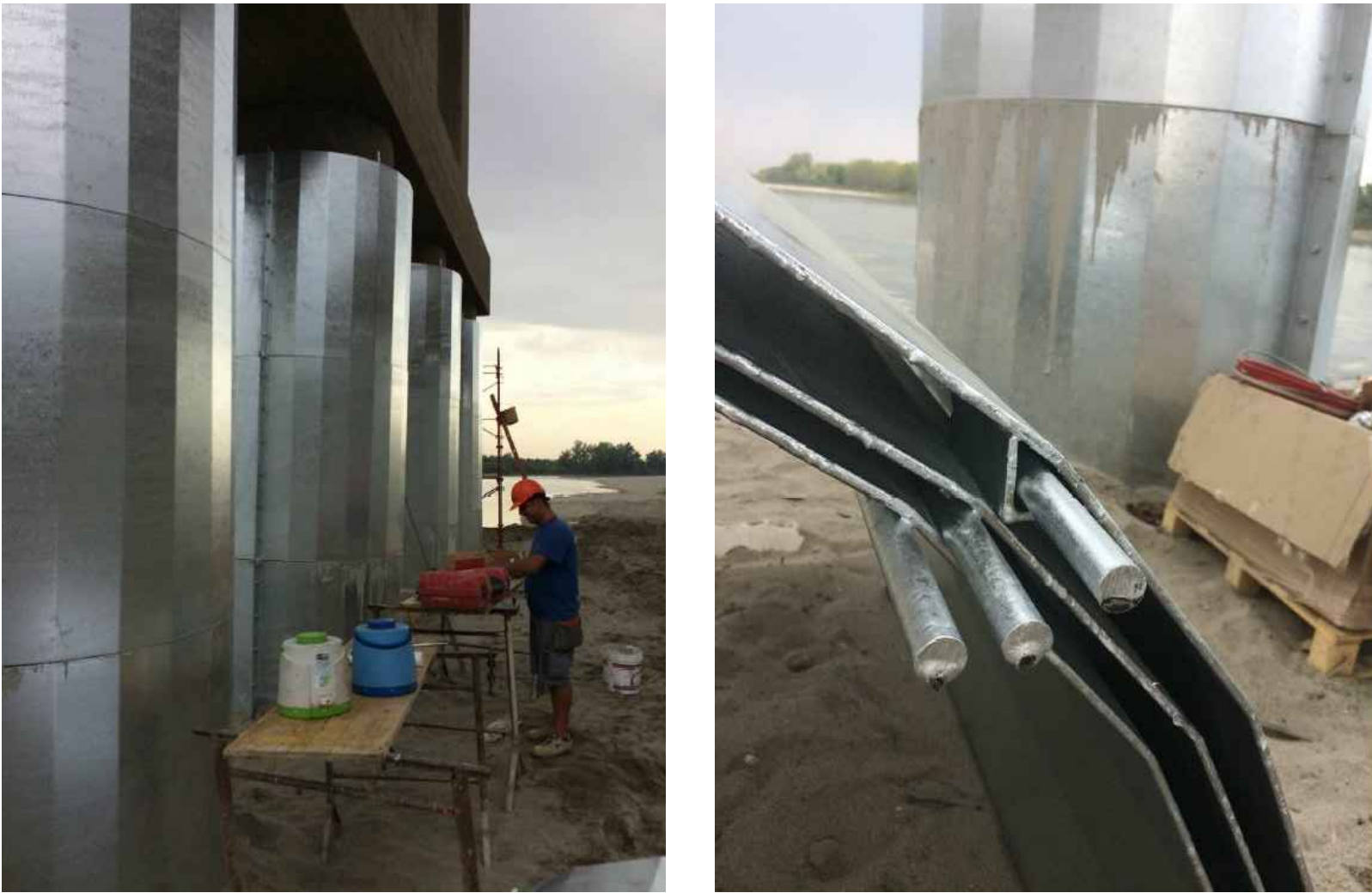
Foto esempio di esecuzione incamiciature presso ponte BORETTO
