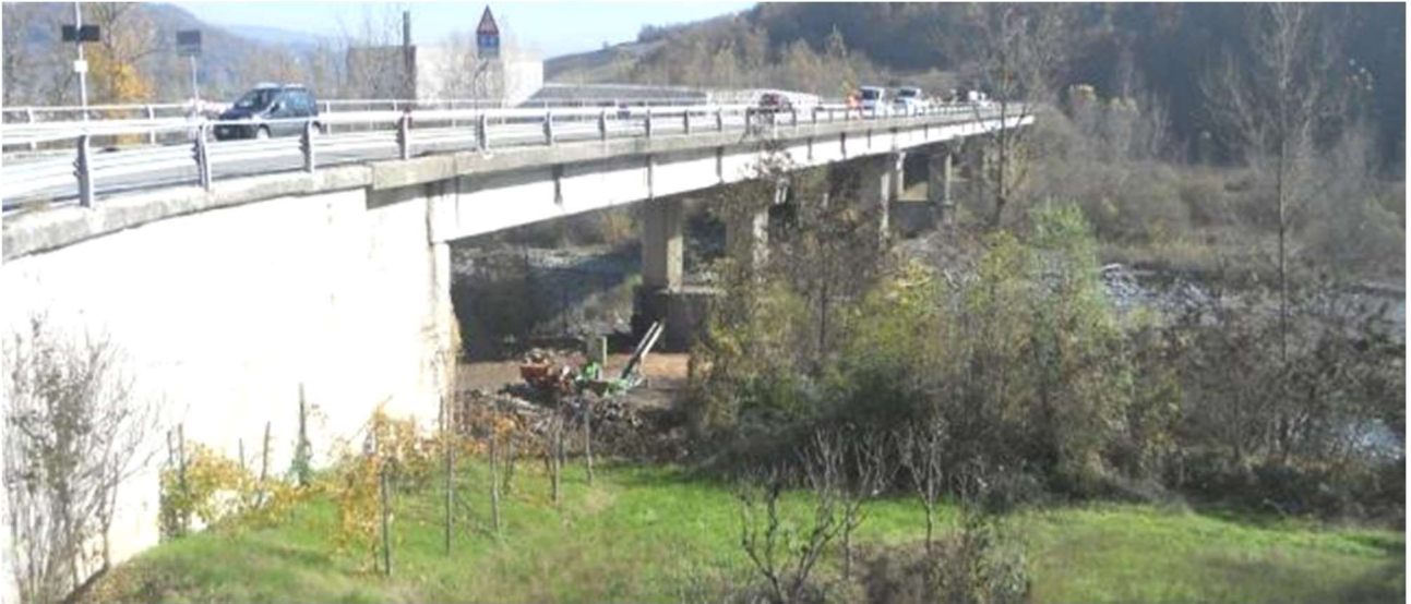
Figura 4 - Vista laterale sud
