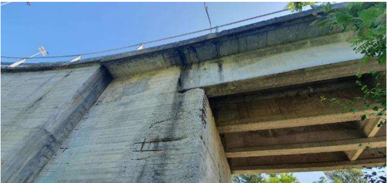
Figura 5 - Vista spalla di appoggio ovest
