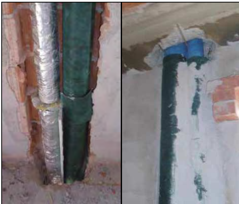
Figura 63: accorgimenti costruttivi (particolari isolamento acustico tubazioni, fonte indexspa.it )
