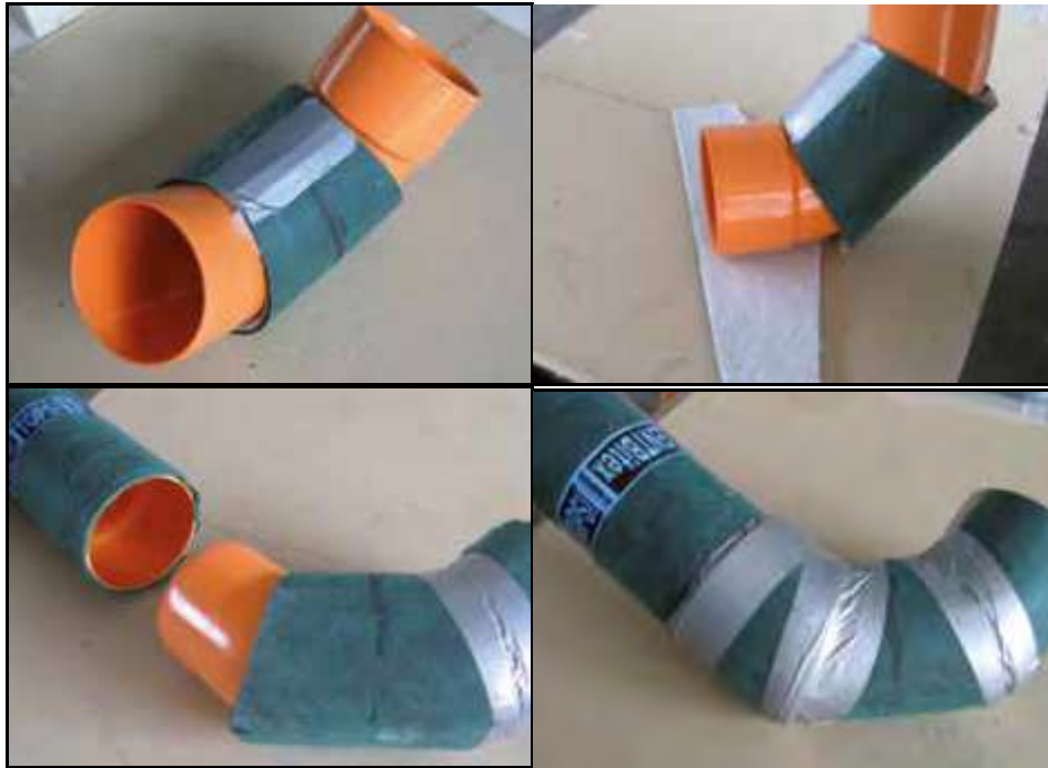
Figura 62: accorgimenti costruttivi (isolamento acustico curva tubazione di scarico, fonte indexspa.it )
