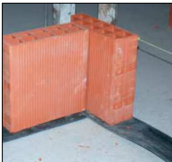
Figura 42: accorgimenti costruttivi (posa fascia tagliamuro sottoparete)
