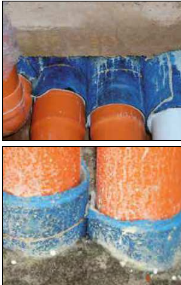
Figura 60: accorgimenti costruttivi (rivestimento impianti nel passaggio solai, fonte indexspa.it )
